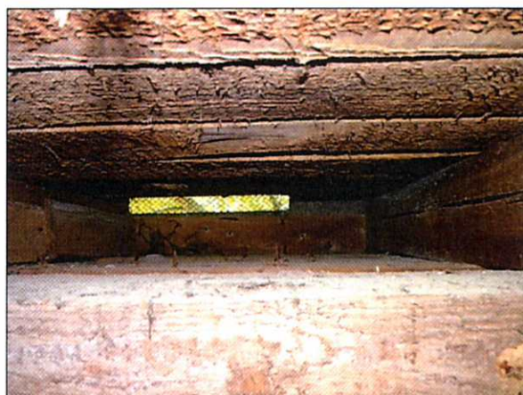
č. 16 Detail VO s kovovou sítíkou, pavilon č. 2
