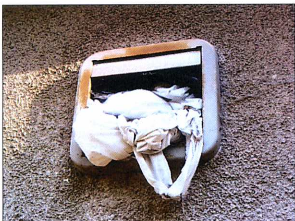
č. 37 Detail zaslepeného VO, prádelenský pavilon
