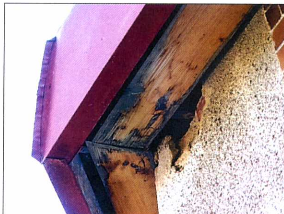
č. 32 Detail poškozeného dřevěného podbití, prádelenský pavilon
